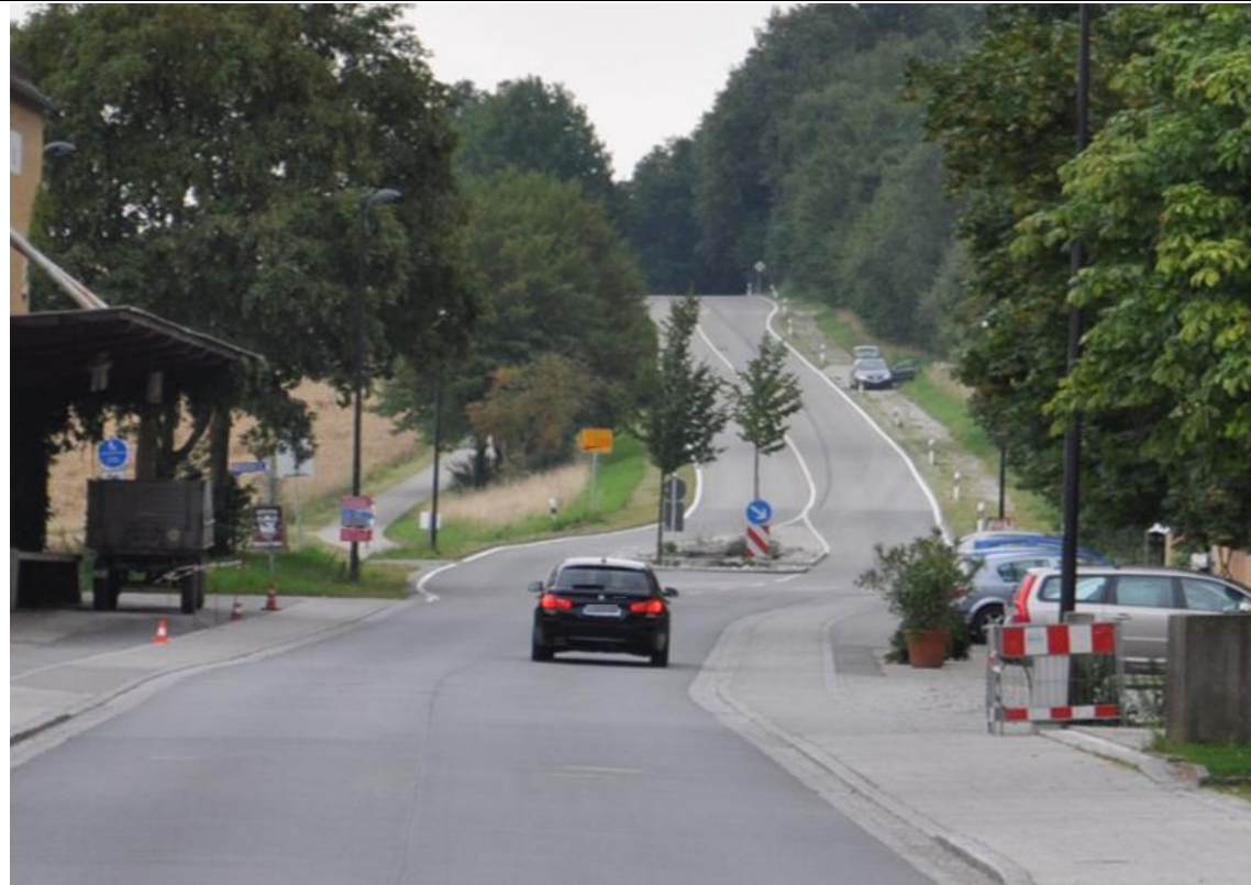
Abbildung 20: Beispiel für eine Verkehrsinsel und Fahrbahnverschwenkung
