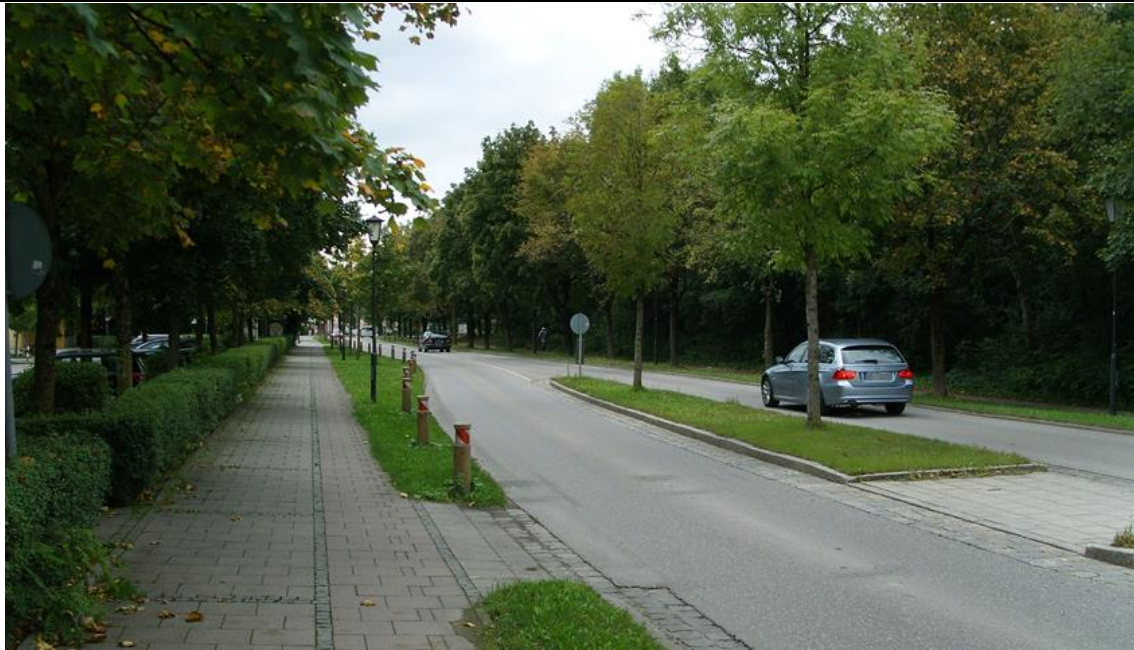
Abbildung 21: Beispiel einer Verengung einer Fahrbahn
